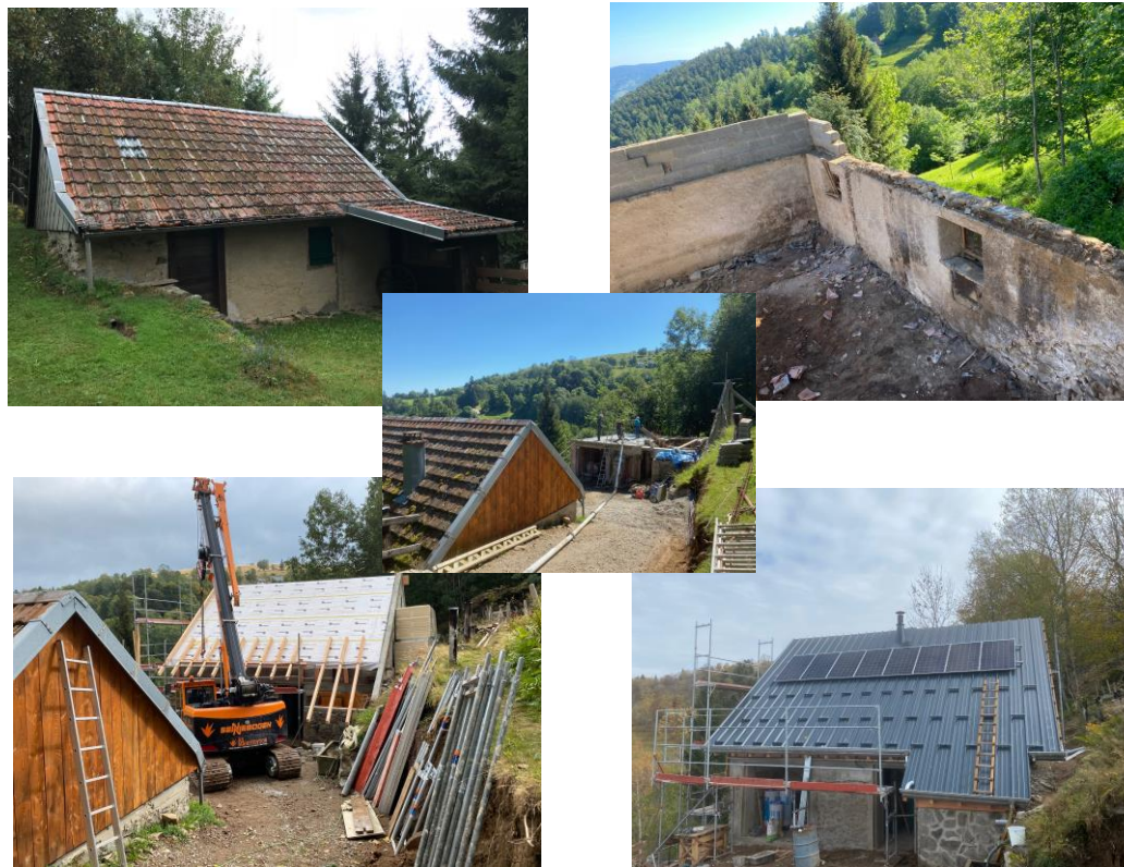
Transformation d'un chalet Kaltwasser
